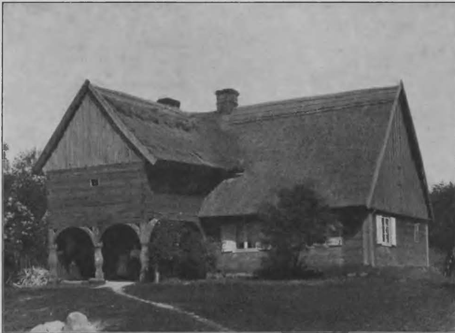
Abb. 42. Vorlaubenhaus mit hölzernem Obergeschoß in Sonnenborn, Kreis Mohrungen.
