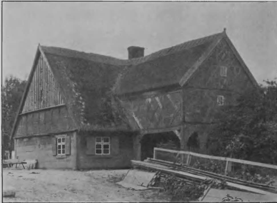
Abb. 43. Dorlaubenhaus mit Fachwerksobergeschoß in Borbeuren, Kreis Pr. Holland.
