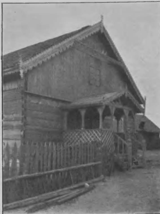
Abb. 1. Wohnhaus in Scharken, Kreis Johannisburg. Erbaut 1906.
