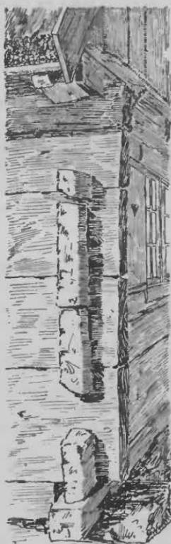
Fig. 7. Bohlwanddeckung in Luxethen, Kreis Pr. Holland.
